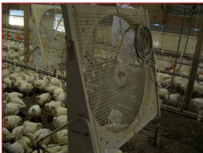
Дополнительно к вентиляторам циркуляции воздуха птичники открытого типа оборудованы мелкодисперсными распылителями (туманоустановки), которые снижают температуру птичника с помощью охлаждения испарением.
