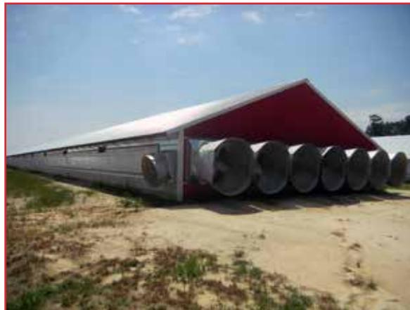
Приточные проемы туннельной вентиляции должны располагаться в противоположном конце птичника. Они должны иметь одинаковую площадь и быть установлены в обеих боковых стенах. Проемы должны закрываться с помощью дверей на петлях или системы полов. Закрытие и открытие автоматическое и работает от общей системы контроля микроклимата.
