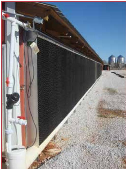
Для эффективной работы туннельной вентиляции важно, чтобы площадь панелей испарения была точно рассчитана в соответствии с общей мощностью осевых вентиляторов.
